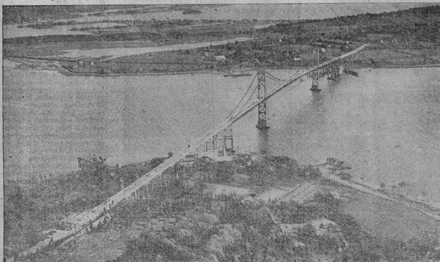
En esta fotografía vemos el puente de Mount Hope, el cual se construyó para poder completar la carretera de Providence, R. I., a Newport. La grandiosa obra de ingeniería se construyó a un costo total de unos 4,000,000 de dólares y tiene 6,130 pies de largo. El paisaje que lo rodea, como puede apreciarse en esta foto, es verdaderamente encantador
